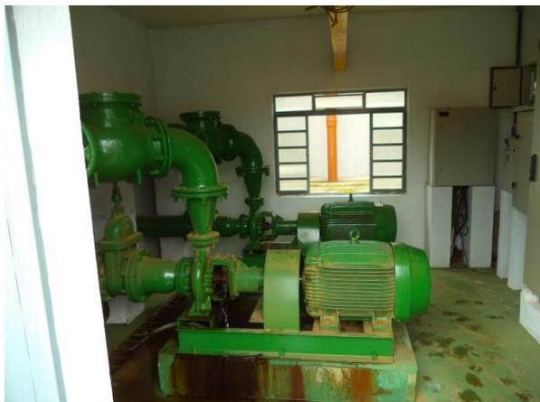
FIGURA 43 – ESTAÇÃO ELEVATÓRIA DE ÁGUA TRATADA (FONTE: VALLENGE, 2014)
