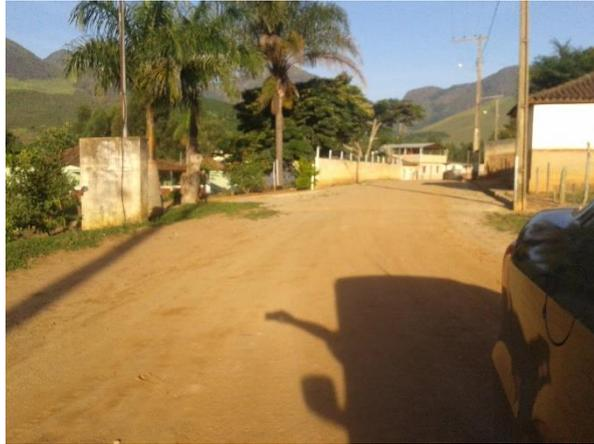
FIGURA 140 – AUSÊNCIA DE DISPOSITIVOS DE MICRODRENAGEM (FONTE: VALLENGE, 2014)
