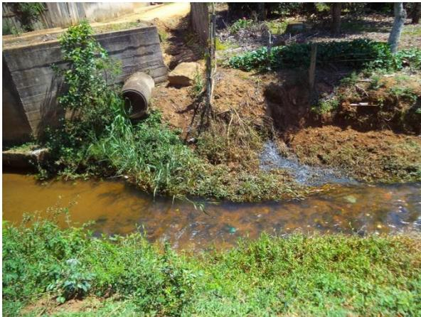
FIGURA 73 – LANÇAMENTO DE ESGOTO (VISTA 1) (FONTE: VALLENGE, 2014)
