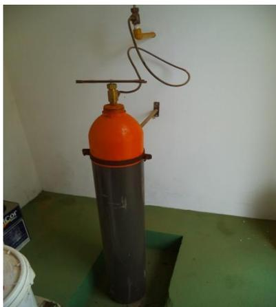
FIGURA 33 – DEPÓSITO DE CLORO A GÁS (FONTE: VALLENGE, 2014)
