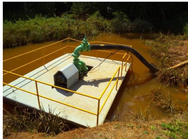
FIGURA 18 – CAPTAÇÃO RIBEIRÃO TURVÃO – BALSA FLUTUANTE (FONTE: VALLENGE, 2014)
