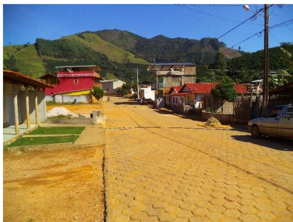
FIGURA 135 – AUSÊNCIA DE DISPOSITIVOS DE MICRODRENAGEM
